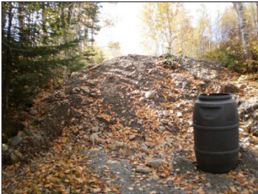
Photographie 4 – Après le creusage d'une tranchée (photographie prise le 30 septembre 2009)
