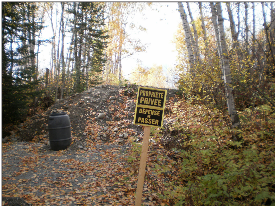
Photographie 2 – Après le creusage d'une tranchée (photographie prise le 30 septembre 2009)
