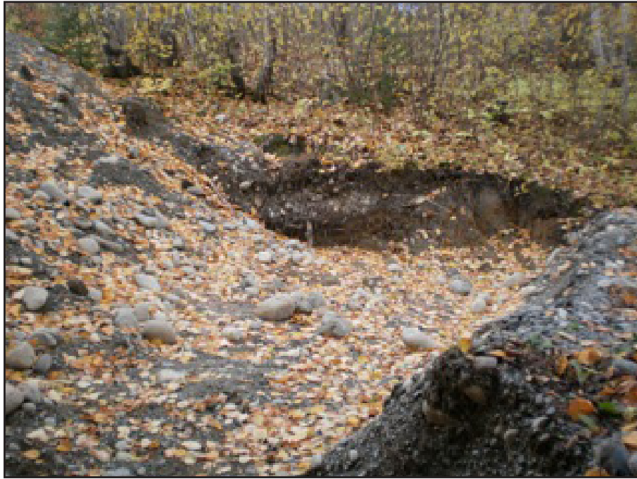
Photographie 3 – Après le creusage d'une tranchée (photographie prise le 30 septembre 2009)
